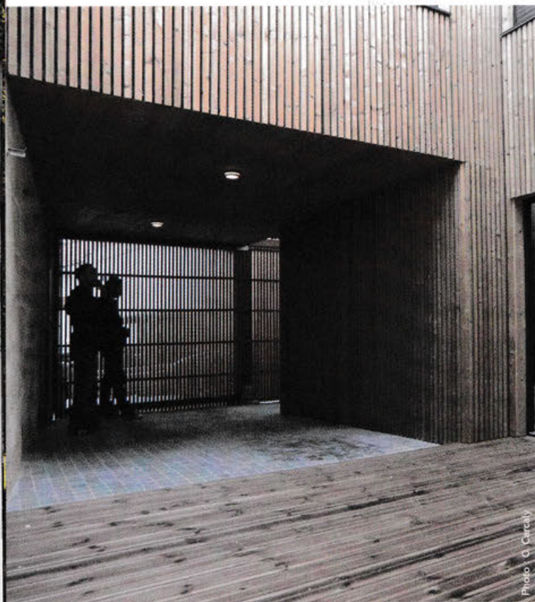
▲ Maison avec une structure porteuse en pin lamellé-collé formant une trame de base cubique. L'habillage extérieur est également en pin. Maison Hausu Meian, Bordeaux (33) – PNCB 2015 – 3 e prix Logements individuels > 120m 2 Shon – Architecte Olivier Carcaly.
